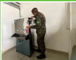
Fig 42. Sd Moro realizando a manutenção de bebedouros e troca de filtros.
